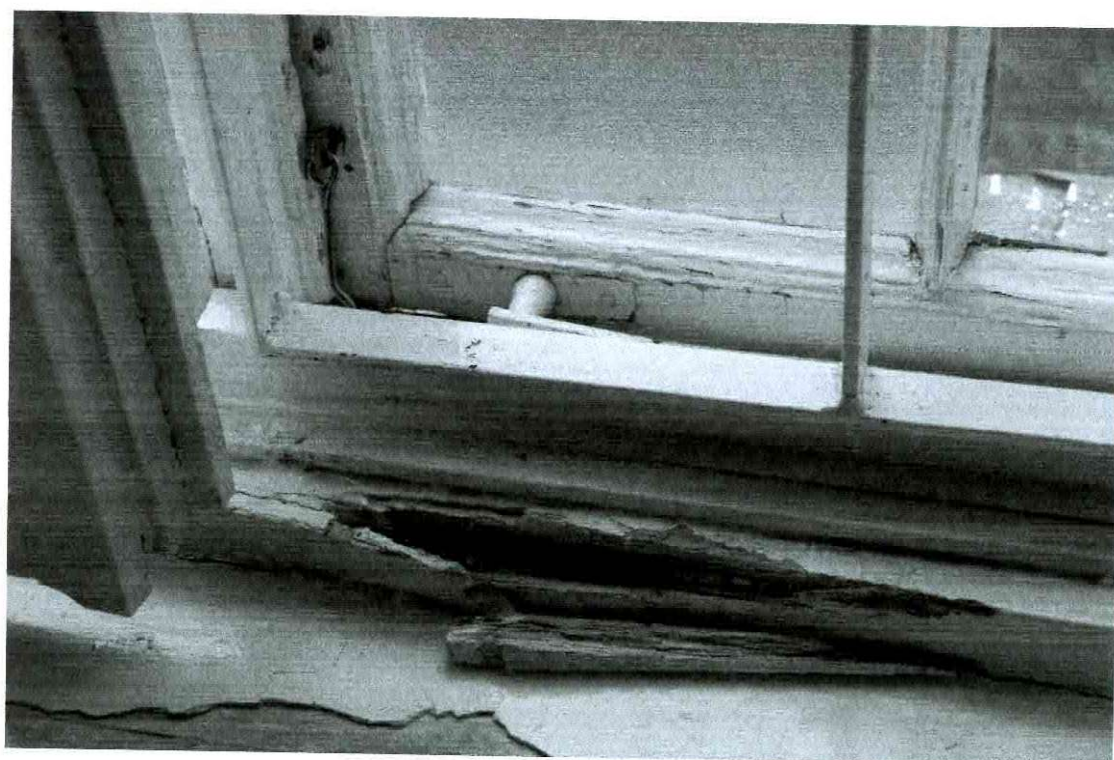
Fot. Nr 14. Radzyń Podlaski, Pałac Potockich, stolarka okienna, stan zachowania, listopad 2008 r.
