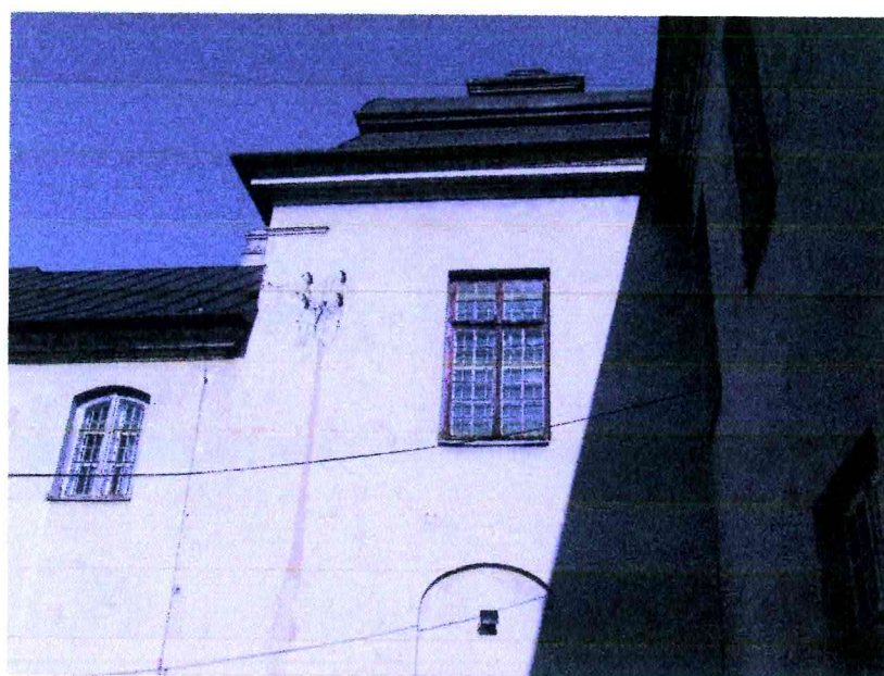
Fot. 8. Articulacja okien w dziedzińcu zachodnim w elewacji północnej, widoczne spękania tynków.
