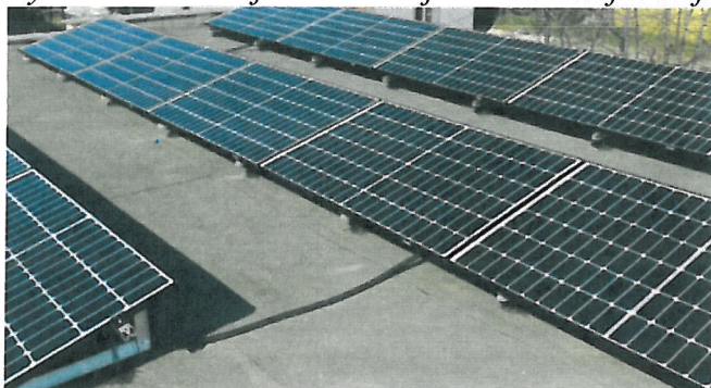
Rys 4. Wizualizacja konstrukcji montażowej umiejscowionej na dachu płaskim
