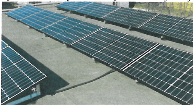
Rys 4. Wizualizacja konstrukcji montażowej umiejscowionej na dachu płaskim
